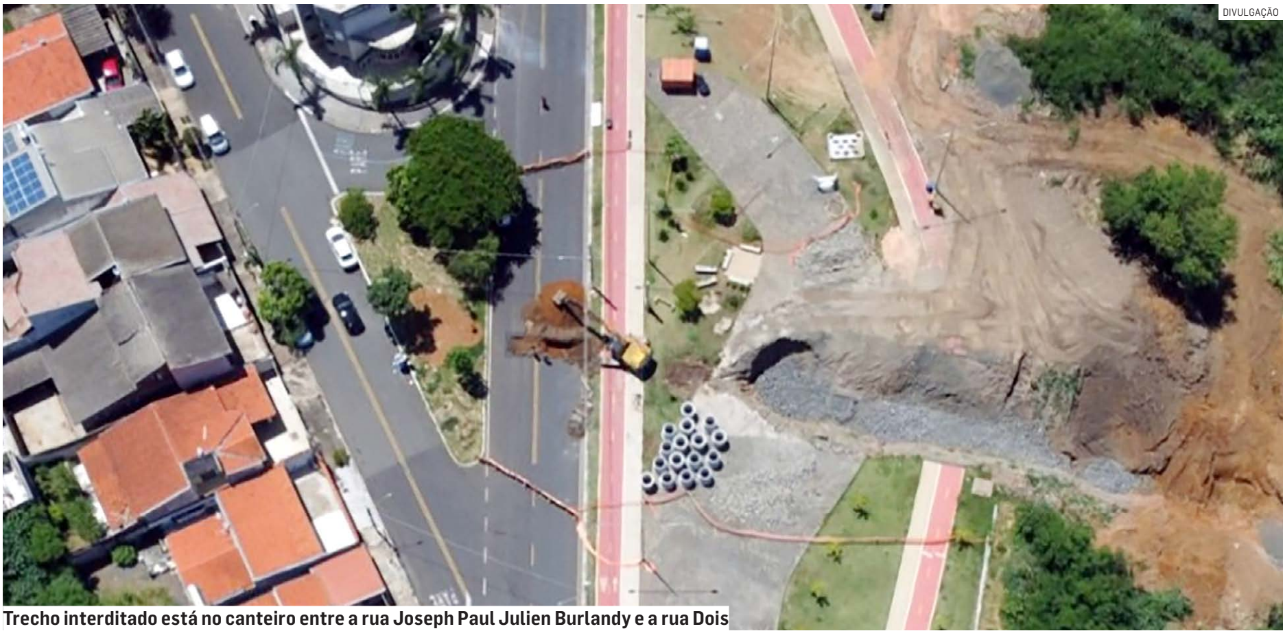
Trecho interditado está no canteiro entre a rua Joseph Paul Julien Burlandy e a rua Dois
