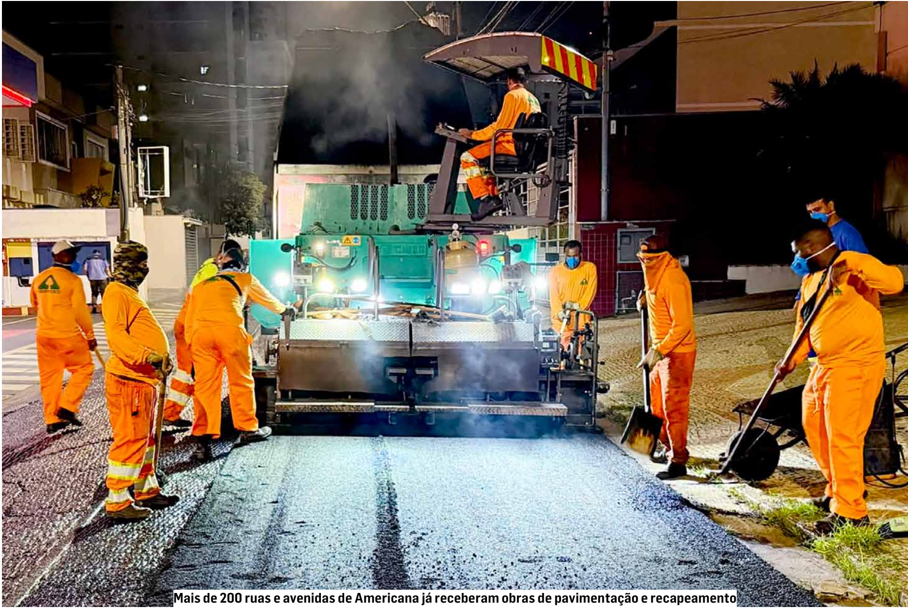
Mais de 200 ruas e avenidas de Americana já receberam obras de pavimentação e recapeamento
