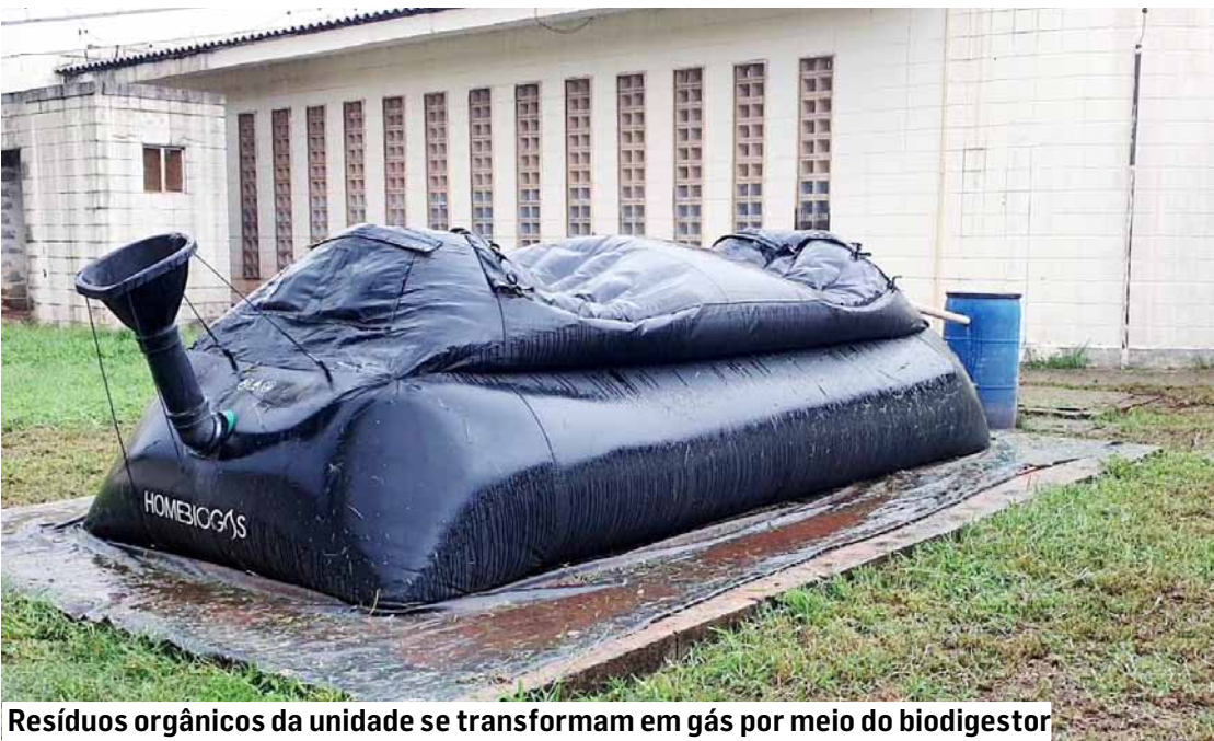
Resíduos orgânicos da unidade se transformam em gás por meio do biodigestor
