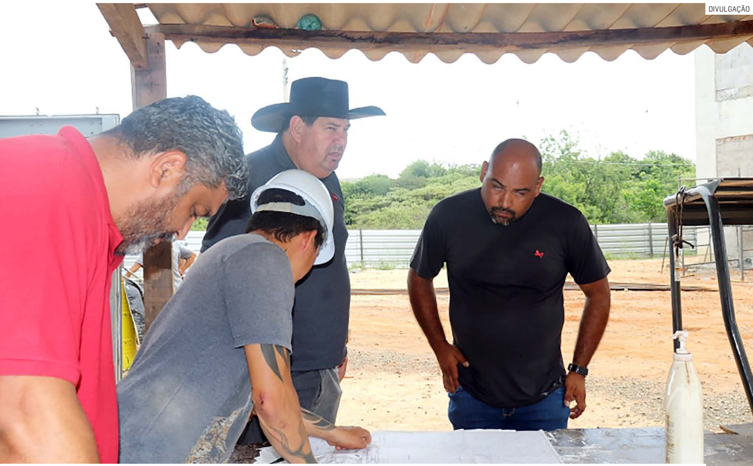
Município diz trabalhar para concluir diversas obras que atendam às demandas essenciais nos bairros de Monte Mor
