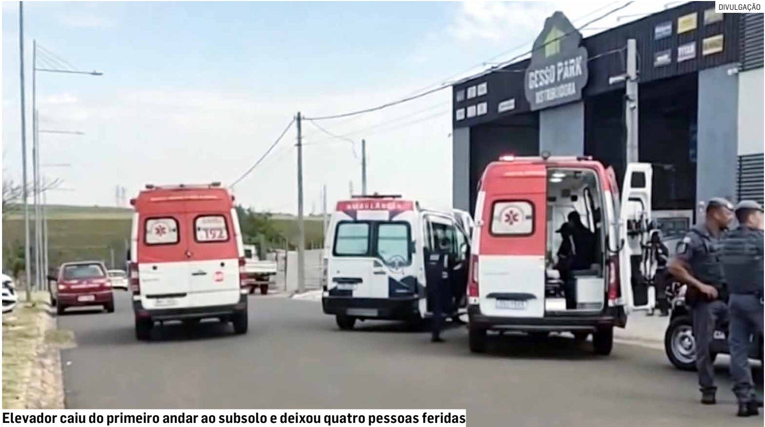
Elevador caiu do primeiro andar ao subsolo e deixou quatro pessoas feridas
