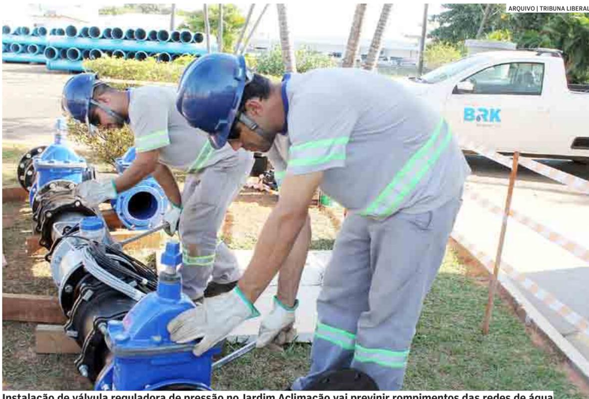
Instalação de válvula reguladora de pressão no Jardim Aclimação vai prevenir rompimentos das redes de água
