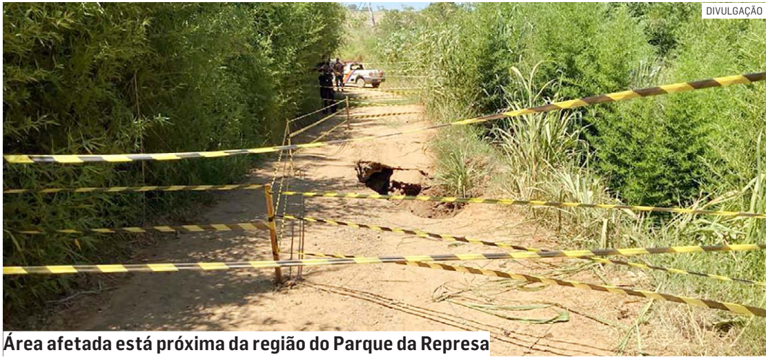
Área afetada está próxima da região do Parque da Represa
