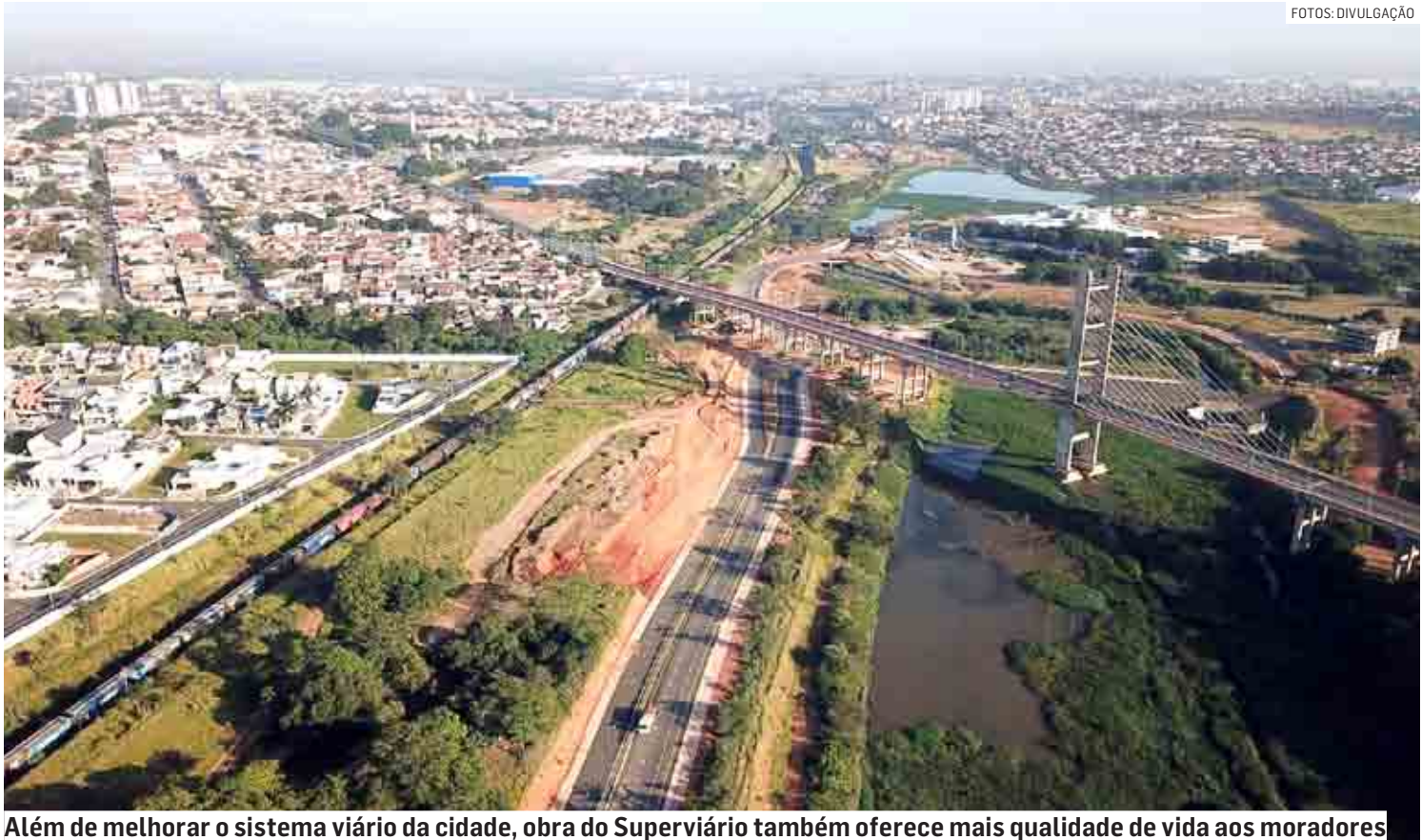
Além de melhorar o sistema viário da cidade, obra do Superviário também oferece mais qualidade de vida aos moradores
