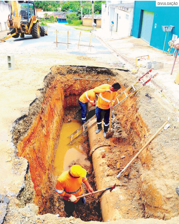
Serviço feito pela Prefeitura de Hortolândia possibilita funcionamento regular das redes de esgoto e águas pluviais
