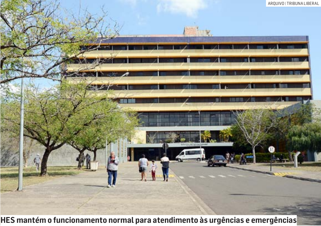
HES mantém o funcionamento normal para atendimento às urgências e emergências
