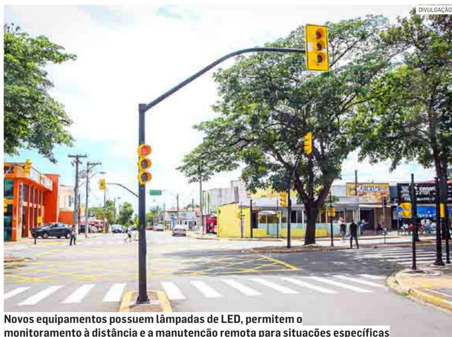
Novos equipamentos possuem lâmpadas de LED, permitem o monitoramento à distância e a manutenção remota para situações específicas
