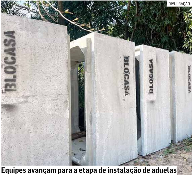
Equipes avançam para a etapa de instalação de aduelas
