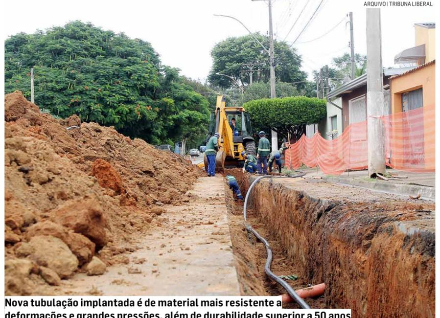
Nova tubulação implantada é de material mais resistente a deformações e grandes pressões, além de durabilidade superior a 50 anos
