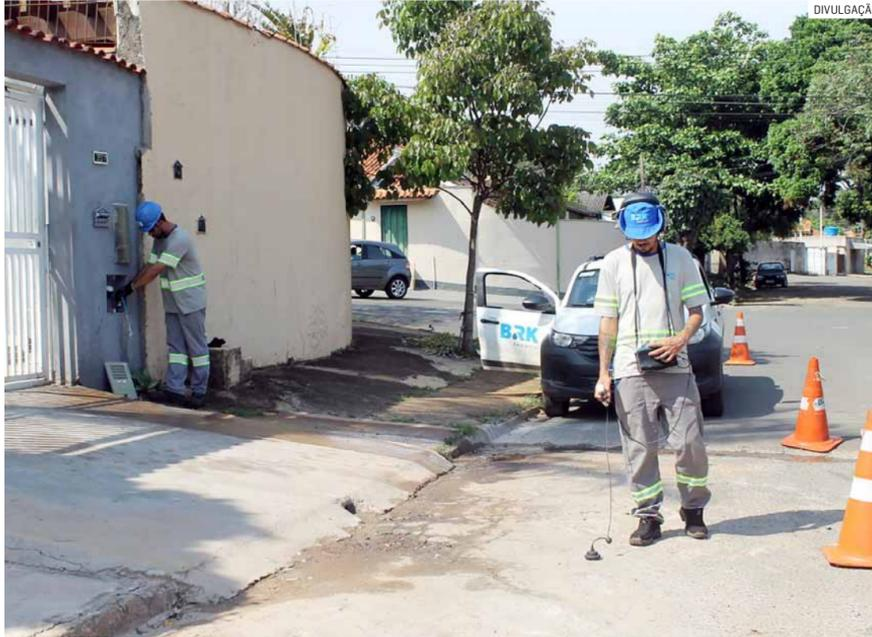
Hasteamento detecta vazamentos não visíveis nas redes e ramais de distribuição de água
