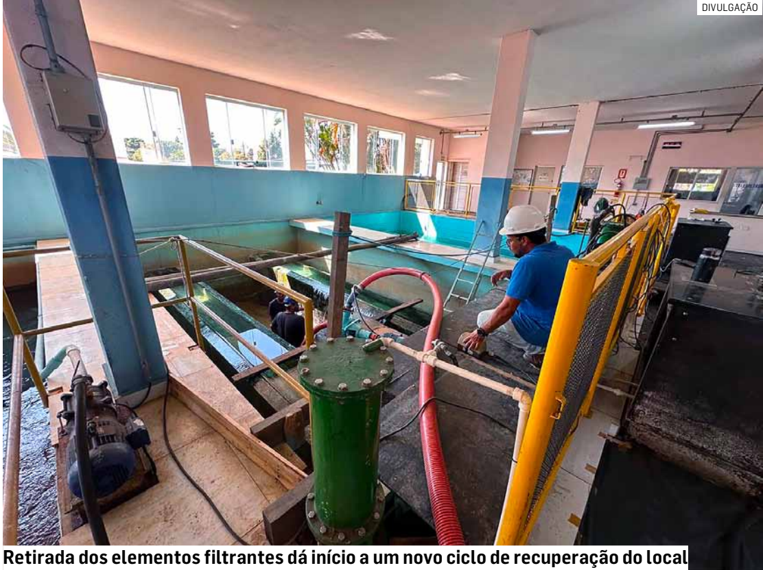
Retirada dos elementos filtrantes dá início a um novo ciclo de recuperação do local
