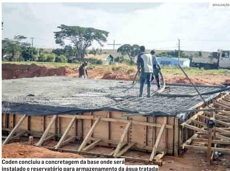
Coden concluiu a concretagem da base onde será instalado o reservatório para armazenamento da água tratada
