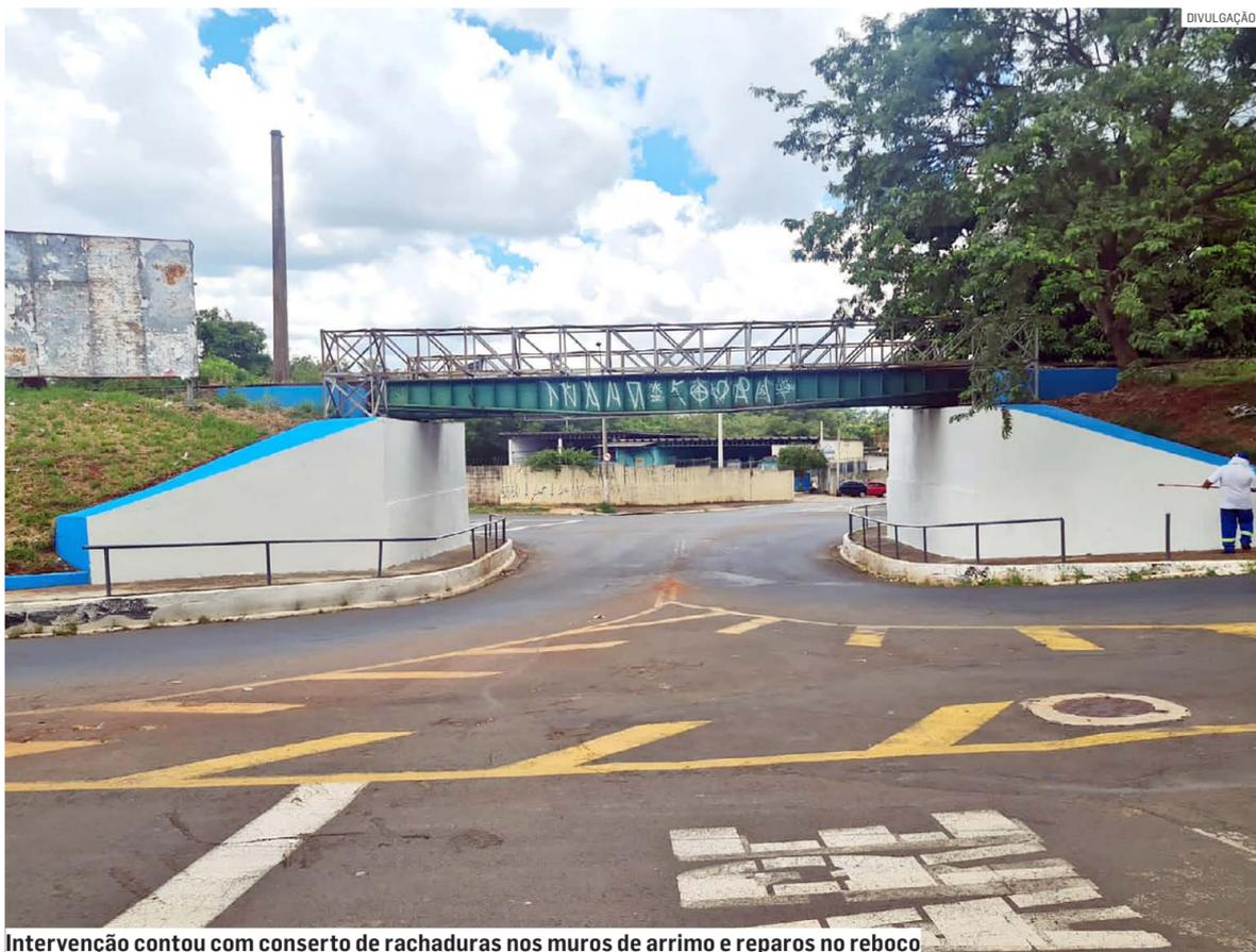
Intervenção contou com conserto de rachaduras nos muros de arrimo e reparos no reboco
