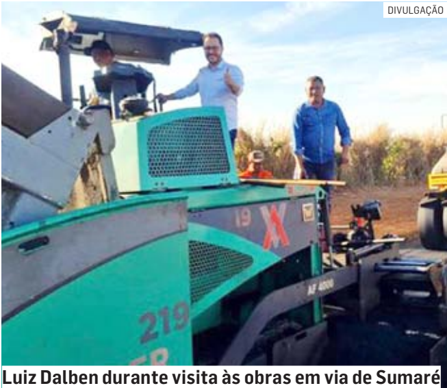
Luiz Dalben durante visita às obras em via de Sumaré
