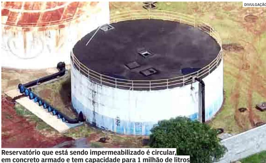
Reservatório que está sendo impermeabilizado é circular, em concreto armado e tem capacidade para 1 milhão de litros
