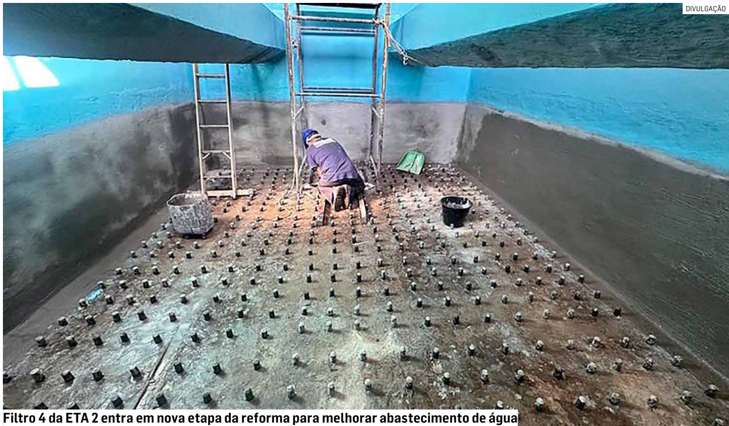
Filtro 4 da ETA 2 entra em nova etapa da reforma para melhorar abastecimento de água
