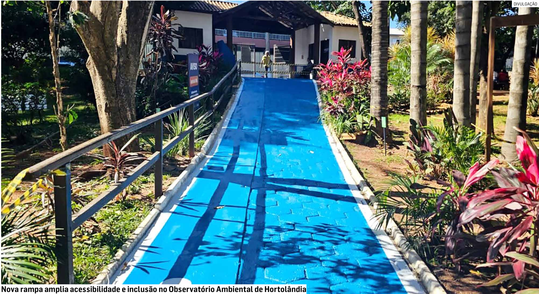
Nova rampa amplia acessibilidade e inclusão no Observatório Ambiental de Hortolândia
