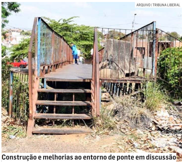
Construção e melhorias ao entorno de ponte em discussão
