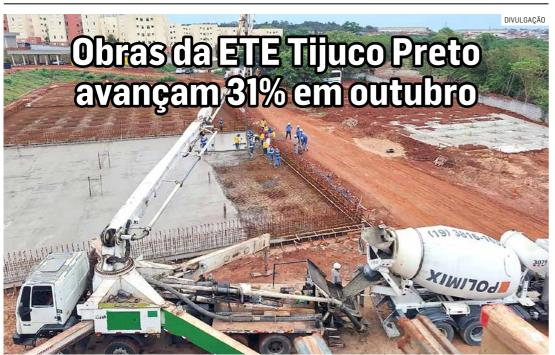
As obras do sistema de tratamento de esgoto Tijuco Preto, em Sumaré, terminaram o mês de outubro com 31% de avanço. Os serviços ocorrem simultaneamente em duas frentes, com a construção da estrutura da nova ETE (Estação de Tratamento de Esgoto) e a implantação de interceptores frente 1. A conclusão e o início da operação estão previstos para 2026. Em novembro, estão previstas a concretagem da laje de fundo de duas estruturas.
