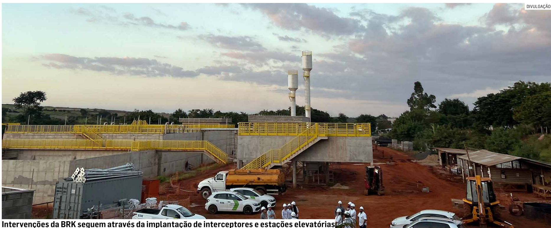
Intervenções da BRK seguem através da implantação de interceptores e estações elevatórias
