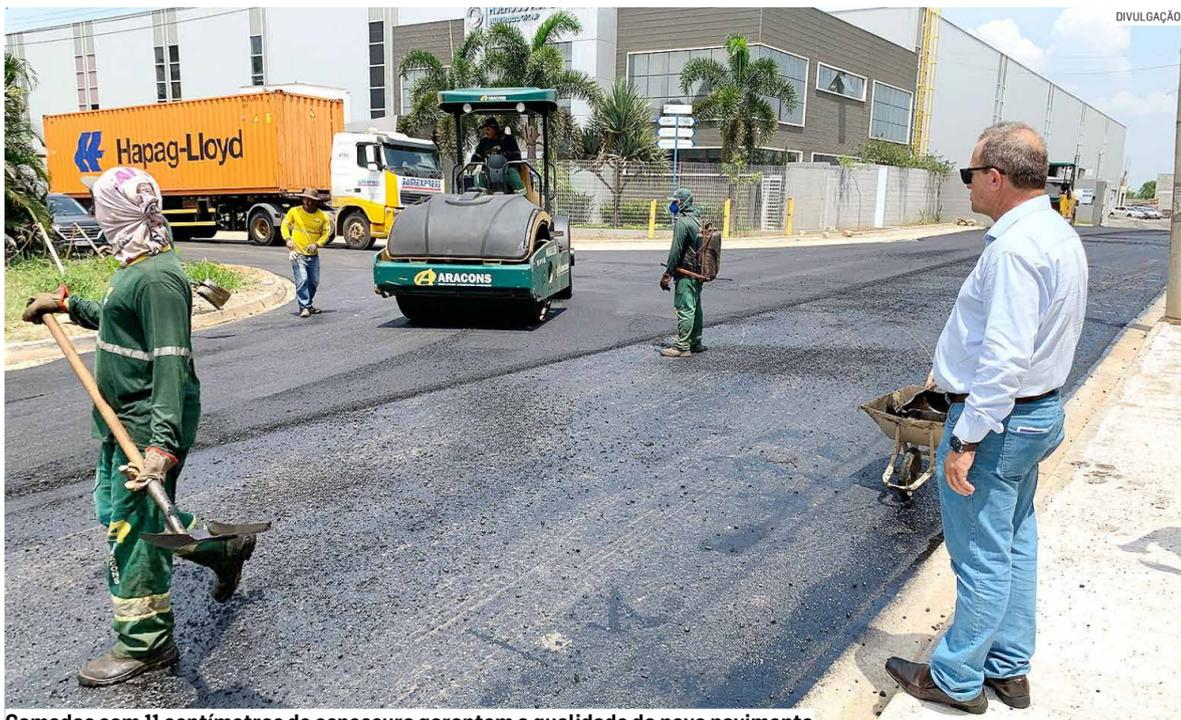
Camadas com 11 centímetros de espessura garantem a qualidade do novo pavimento
